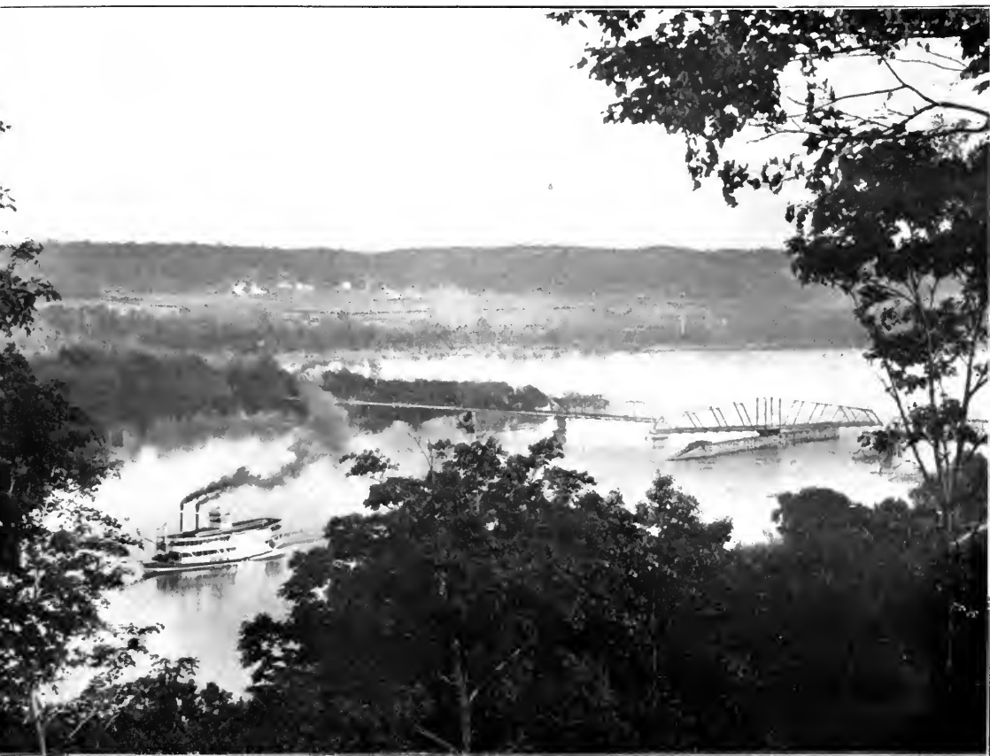
Ein Blick von der Höhe der neuen Mee-Anlage auf die sog. „Narrows“ und die obere Brücke.
